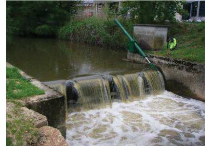
Il n'y avait sur cet ouvrage, aucun règlement d'eau et donc aucune côte légale. L'ouvrage n'était pas équipé de système d'exploitation de la force motrice. Cet ouvrage, situé en amont immédiat de la confluence avec la Sarthe, entravait fortement la continuité sur l'ensemble de ce segment. La franchissabilité piscicole de l'obstacle était très difficile. La présence du clapet favorisait le colmatage des sédiments grossiers en amont par les fines.
