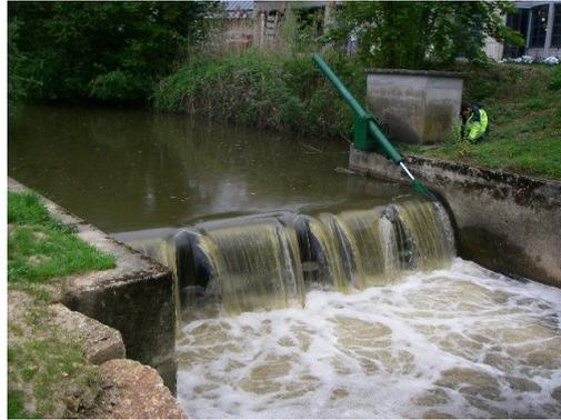
Il n'y avait sur cet ouvrage, aucun règlement d'eau et donc aucune cote légale. L'ouvrage n'était pas équipé de système d'exploitation de la force motrice. Cet ouvrage situé en amont immédiat de la confluence avec la Sarthe entravait fortement la continuité sur l'ensemble de ce segment. La franchissabilité piscicole de l'obstacle était très difficile. La présence du clapet favorisait le colmatage des sédiments grossiers en amont par les fines.
